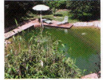
Keçe ve folyo ile kaplanan yüzme göletinin bitmiş hali. Rejenerasyon alanı teçhiz edilmiş, teknik aksam devrede ve platform, yüzme eğlencesinden sonra tam suyun yanında harika bir yer sunuyor.
